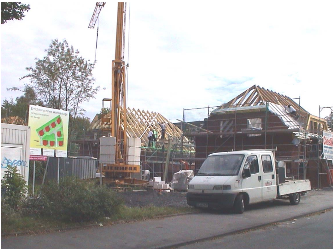
Bau von 16 Doppelhaushälften an der Zeppelinstraße
